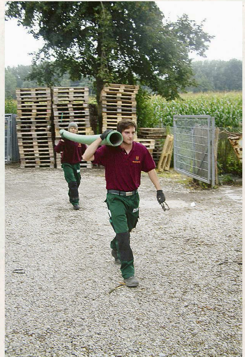
Johannes Sedlmayer (vorne) beim Rohre-Schleppen.
